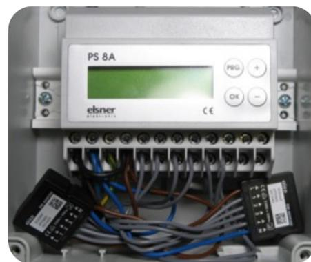
**Bild 24:** Anschluss der Digital Strom SW-AKM200-Klemmen an eine Wetterstation (Quelle: R. Englert)
