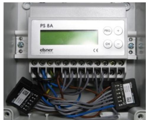
**Bild 24:** Anschluss der digitalSTROM SW-AKM200-Klemmen an eine Wetterstation (Quelle: R. Englert)
