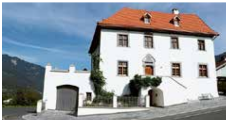
■ Das denkmalgeschützte Patrizierhaus aus dem 16. Jahrhundert ist heute ein Smart Home.
