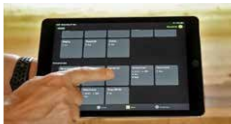
L'éclairage, les stores, le chauffage, la ventilation, l'alarme, l'audio, la vidéo ainsi que les appareils électriques de la cuisine et de la buanderie peuvent être commandés par bouton-poussoir ou via application.
